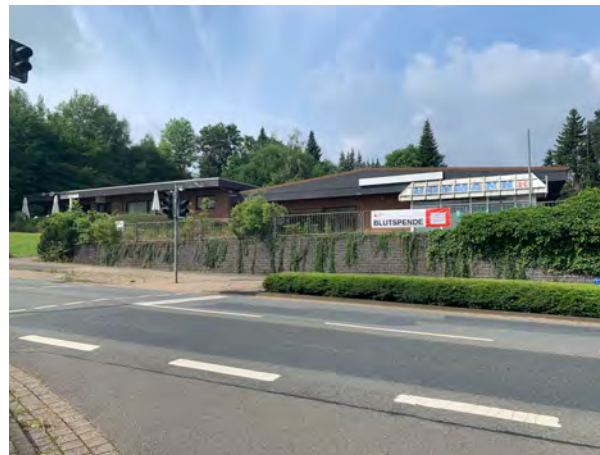
Kreuzungsbereich Bahnhofstr./Bückerburger Str., Blickrichtung Westen: Gastronomie sowie leergefallenes Kleinzentrum
